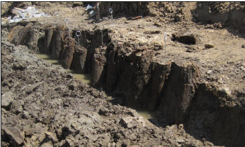
Figuur 17: Palenrij ter hoogte van segment.
