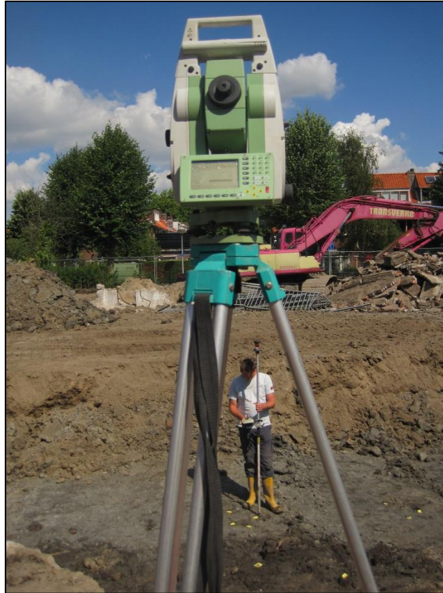
Figuur 4: Het inmeten van sporen met behulp van een robotic Total Station (rTS).
